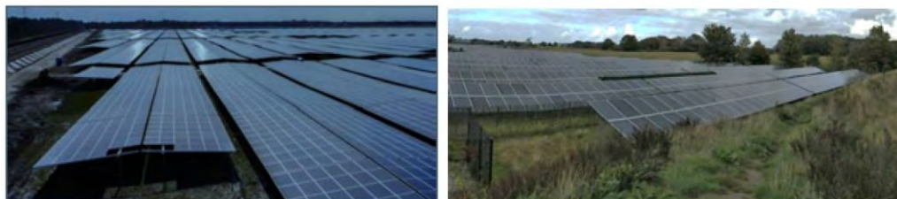
Figuur 11.8 Zuid-opstelling (links) en Oost-West opstelling (rechts)
