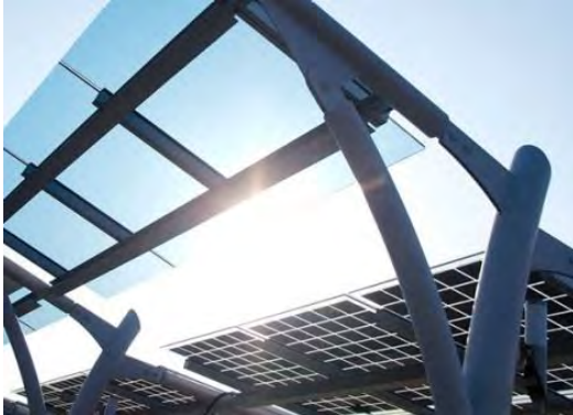
Figuur 3.4: Voorbeeld van licht doorlatende (rechts) en transparante (links) PV-panelen. (Bron: zonnepanelen.nl)
