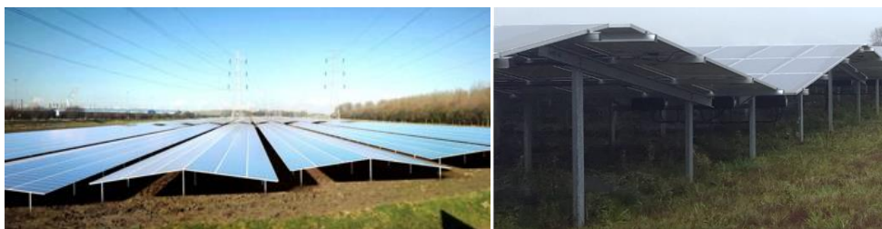
Figuur 3.2 Voorbeelden aanzicht panelen met oost-west oriëntatie
