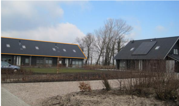
Een flink zadeldak waarop matte zonnepanelen nauwelijks afsteken bij de donkere dakpannen.
