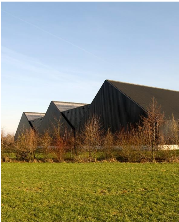
Een geleding in de kopse gevel verzacht grote schaa sprongen.
