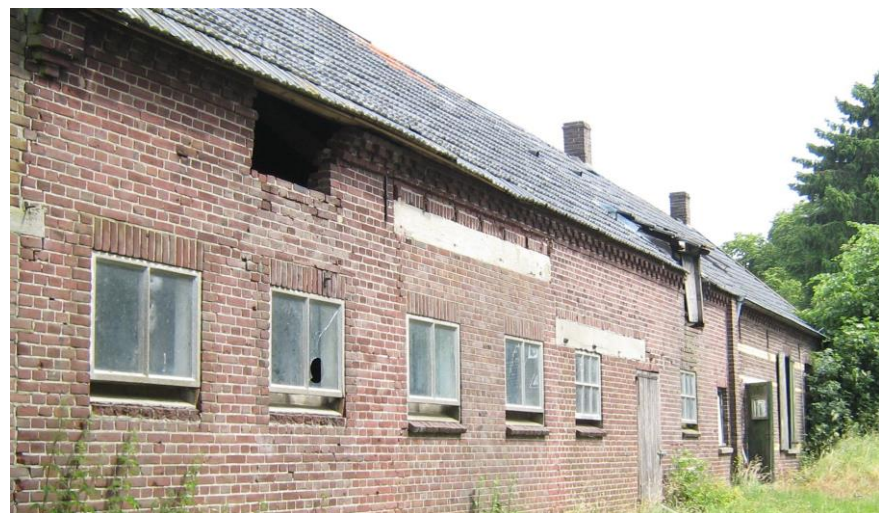
De meeste bebouwing in het buitengebied is snel na de oorlog gebouwd. In deze periode werd metselwerk onder de dakgoot overgenomen van het eerder gebouwde voorhuis. Ook betonnen kozijnen zijn kenmerkend voor deze periode.
