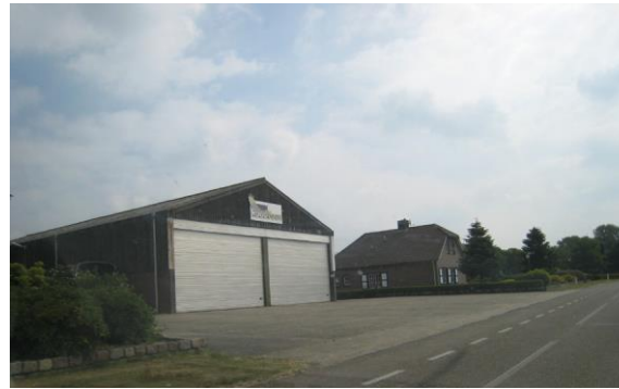
Werken langs de provinciale weg.
