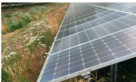
Figuur 4.7: Referentiebeeld oost-westopstelling
